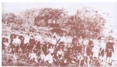
ภาพที่ 32 คนงานก่อสร้างเส้นทางรถไฟกรุงเทพ-นครราชสีมา
