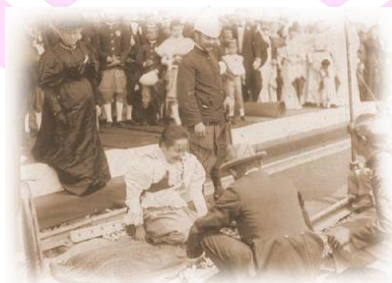
ภาพที่ 33 รัชการที่ 5 ทรงเสด็จเปิดเส้นทางรถไฟสายกรุงเทพฯ-นครราชสีมา
